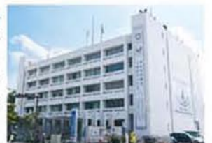
現在の本庁舎は、窓口や待合場所の不足も課題となっている
