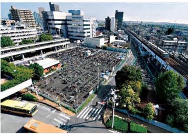
建設予定地となった厚木バスセンター東側
