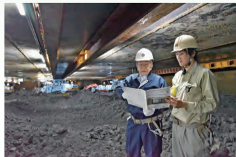
加圧された掘削現場を視察
