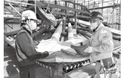
屋根の修理をする大工と設計図を使い完成イメージを共有する松枝さん(右)
