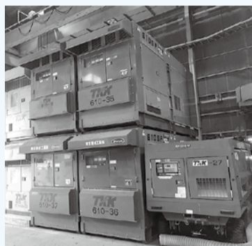
水中ポンプの電力を供給する大型発電機
