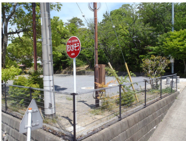
防火水槽完成写真（林中公園）
