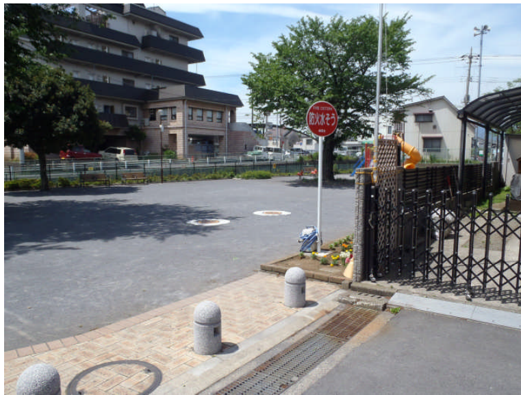
防火水槽完成写真（中村橋公園）
