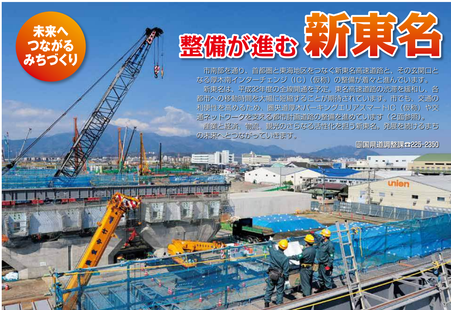
伊勢原方面への建設が進む新東名高速道路
