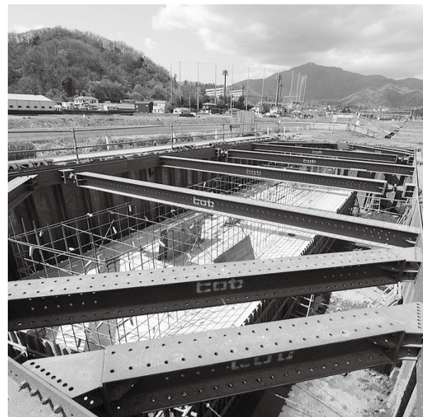
赤坂竹ノ内線の整備に伴い玉川に建設中の橋台
