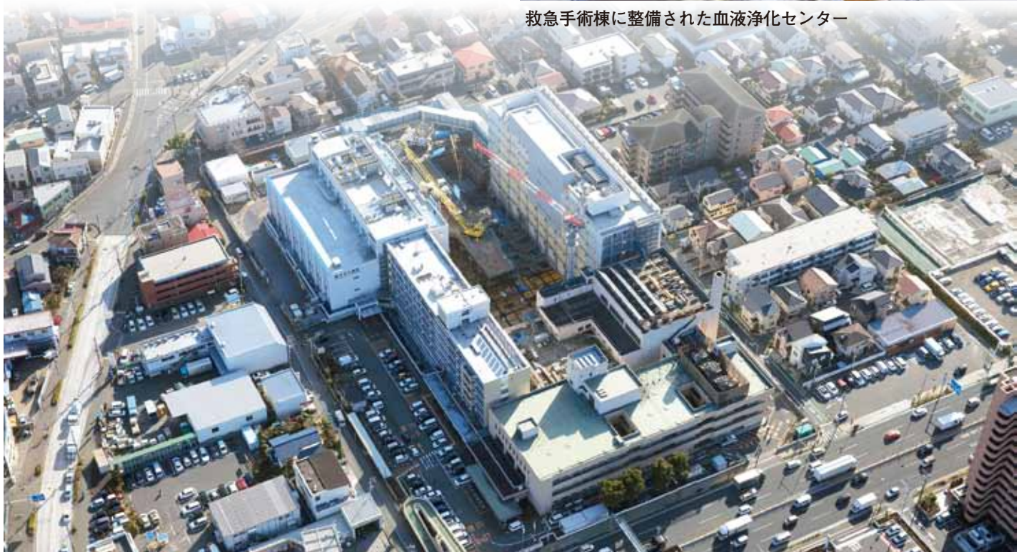
上空から撮影した工事中の市立病院
