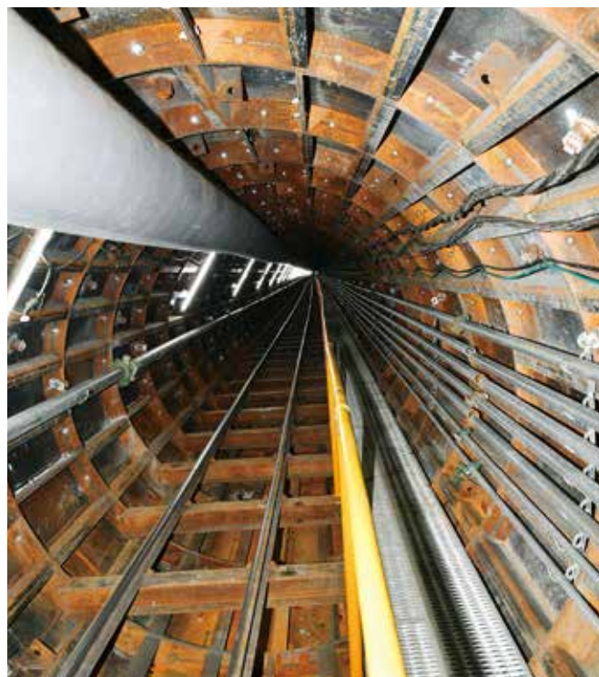
工事中の貯留管
