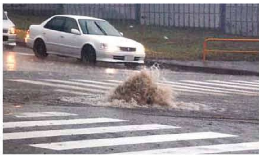
大雨でマンホールから水が噴き出すことも
