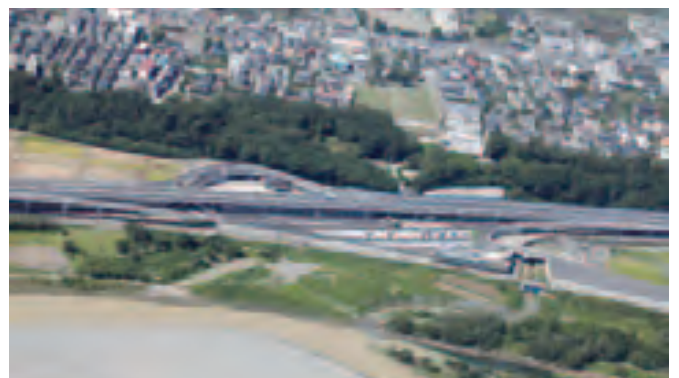
上空から見た厚木パーキングエリア
