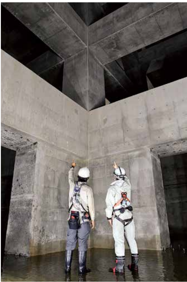
8月末に完成したあさひ公園地下の雨水貯留施設。10月の台風19号の際に効果を発揮した
