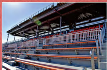
客席に手すりを新設した他、防水加工により雨漏りを防止
