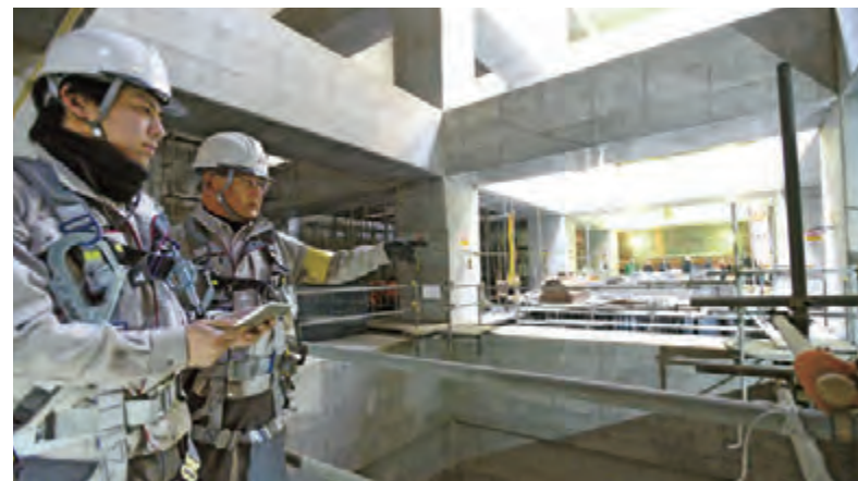
浸水被害対策のため、あさひ公園地下に整備中の雨水貯留施設は8月に完成予定
