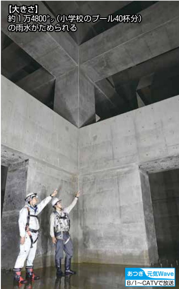
8月末に完成するあさひ公園の雨水貯留施設の内部
